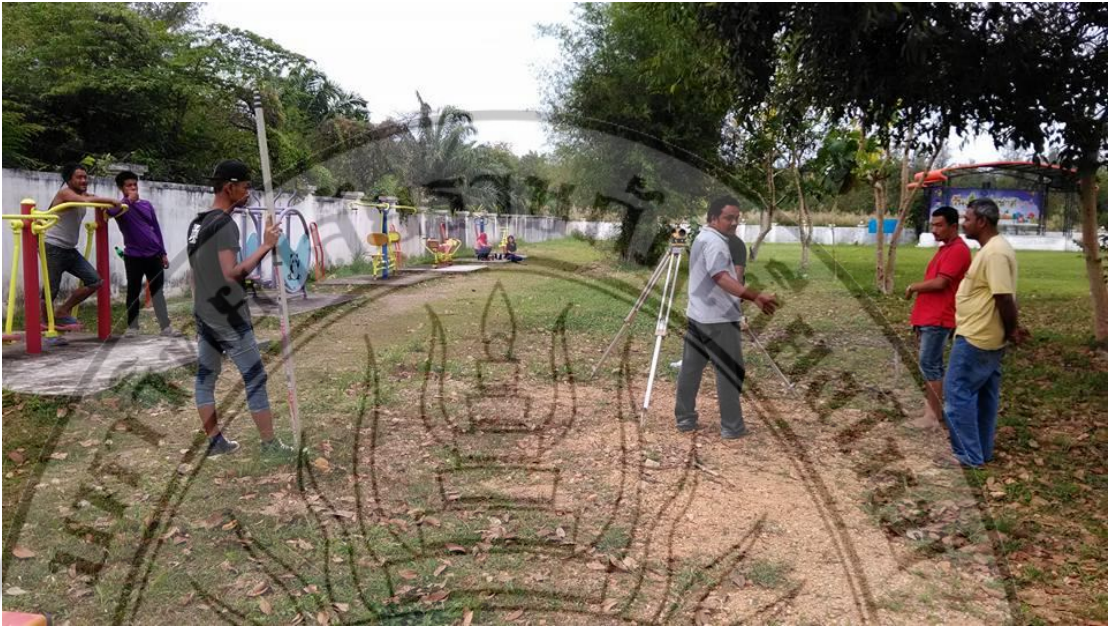
รูปที่ 2. นายช่างผู้ควบคุมตรวจสอบค่าระดับของถนน
