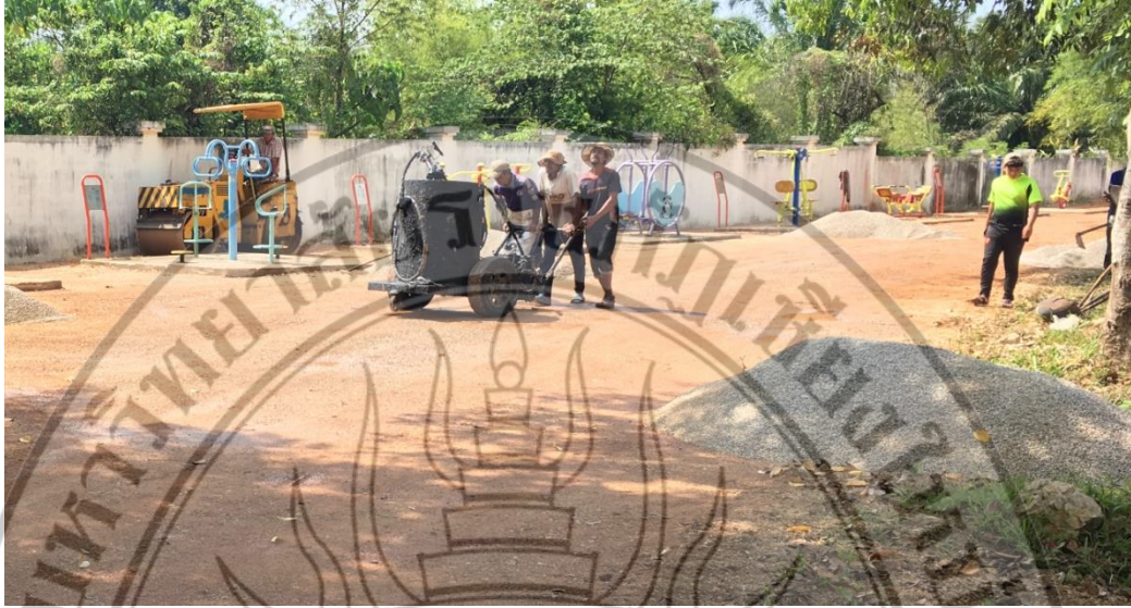
รูปที่ 4. เตรียมงานชั้นพื้นทางและเครื่องจักรงานไพรมโคท (Prime Coat)
