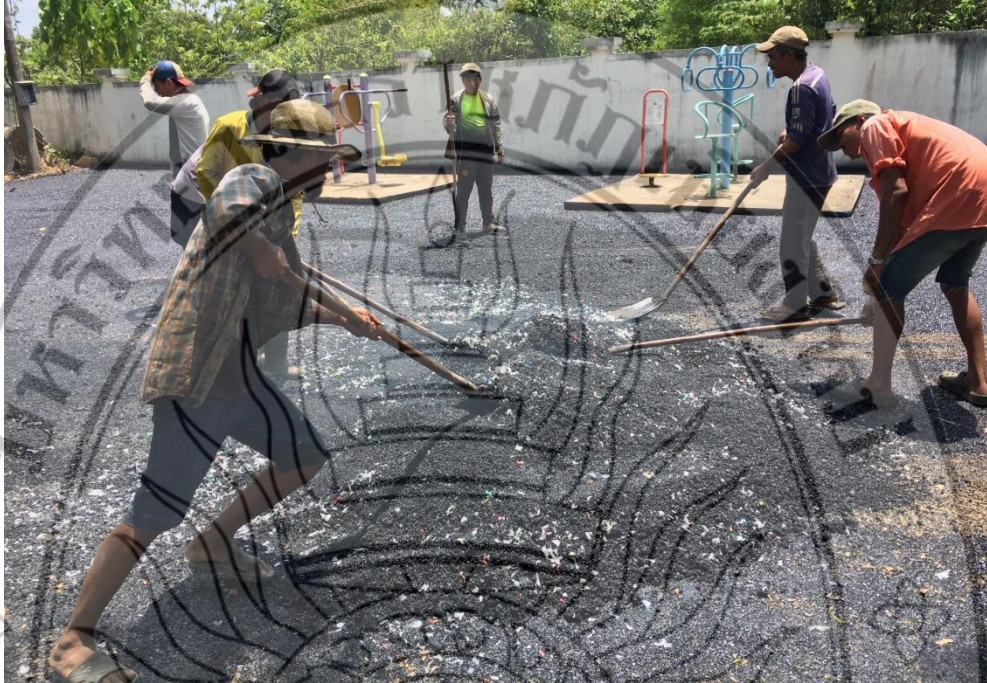
รูปที่ 8 การผสมขยะถุงพลาสติกด้วยแรงงานคน
