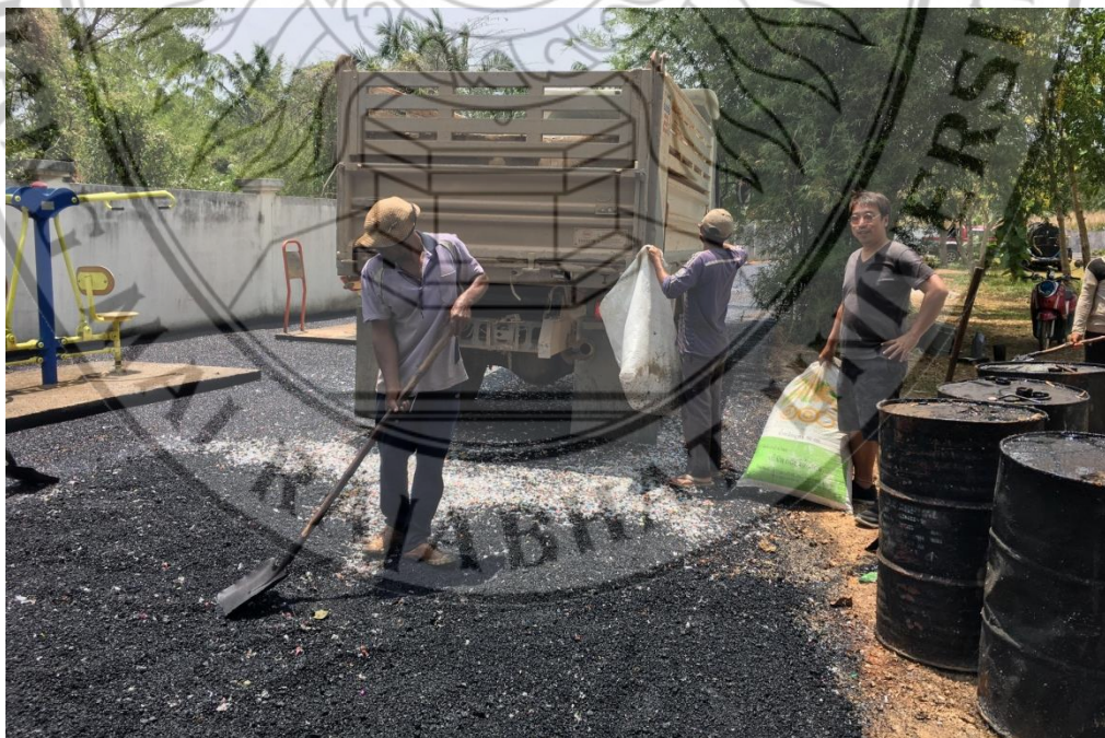
รูปที่ 7 การผสมขี้ชะงูพลาสติกด้วยแรงงานคน
