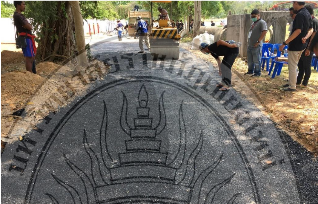
รูปที่ 11 บดอัดผิวทางพาราแอสฟัลต์คอนกรีตผสมขยะถุงพลาสติกด้วยเครื่องจักร
