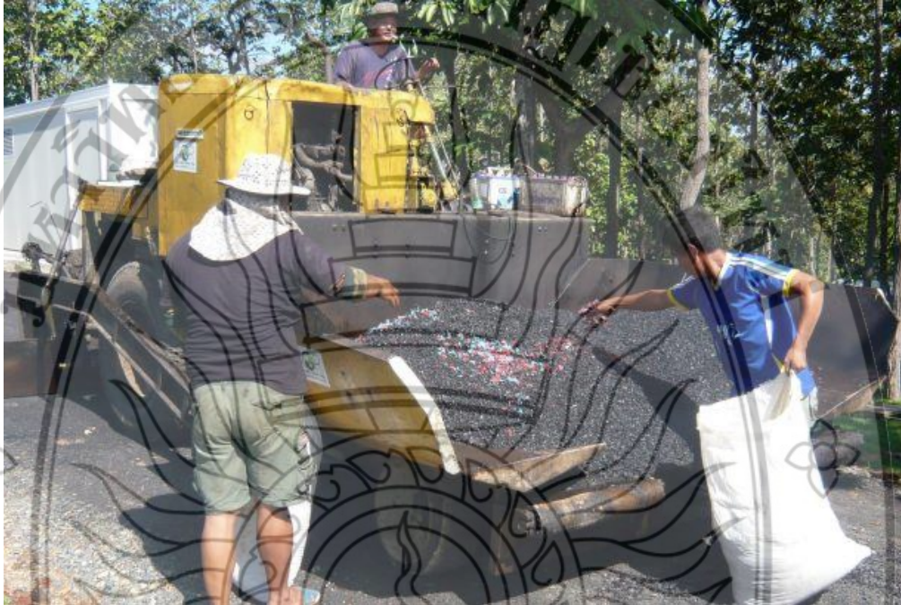
รูปที่ 6 การผสมขี้ชะงูพลาสติกในเครื่องจักรปูถนน
