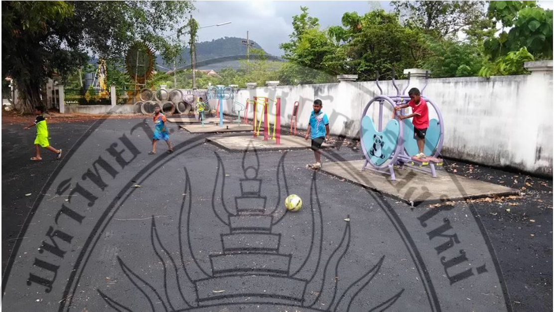
รูปที่ 12 ถนนพาราแอสฟัลต์คอนกรีตผสมขยะถุงพลาสติกต้นแบบ
