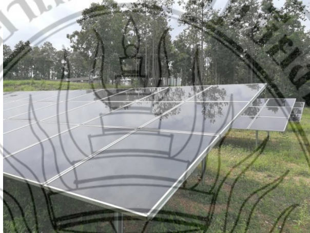
รูปภาพ 2.4 แผงเซลล์แสงอาทิตย์ชนิดฟิล์มบาง
