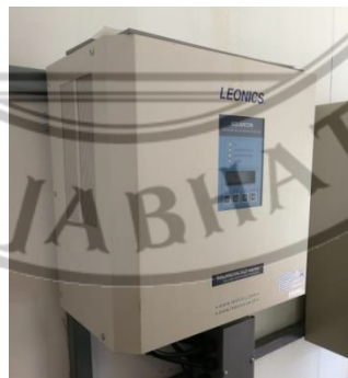
รูปภาพ 2.8 เครื่องควบคุมการประจุแบตเตอรี่แบบ MTPP
