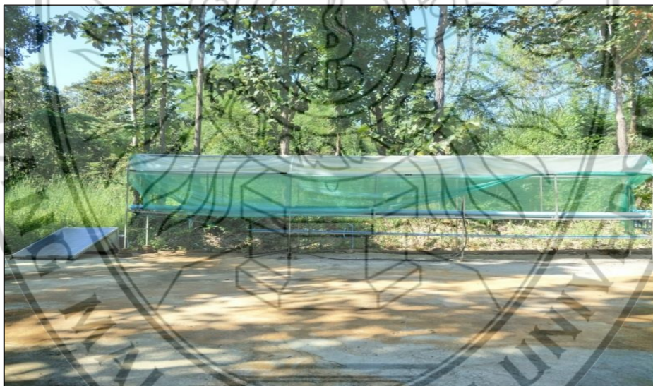
ภาพที่ 4.1 โรงเรือนสำหรับปลูกพืชไฮโดรโปนิคส์ โดยใช้ระบบไฟฟ้ากระแสตรงจากเซลล์แสงอาทิตย์ สำหรับระบบปั๊มสารละลาย และระบบควบคุมอุณหภูมิของพืชไฮโดรโปนิคส์
