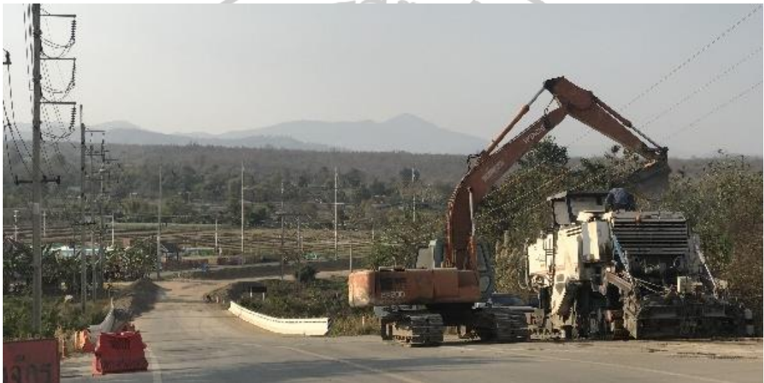
ภาพที่ 4.3 การซ่อมบำรุงถนนสายเฉลิมพระเกียรติ อำเภอปาย จังหวัดแม่ฮ่องสอน
