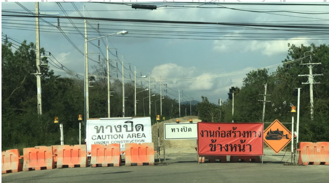
ภาพที่ 4.4 การซ่อมบำรุงถนนสายเฉลิมพระเกียรติ อำเภอปาย จังหวัดแม่ฮ่องสอน
