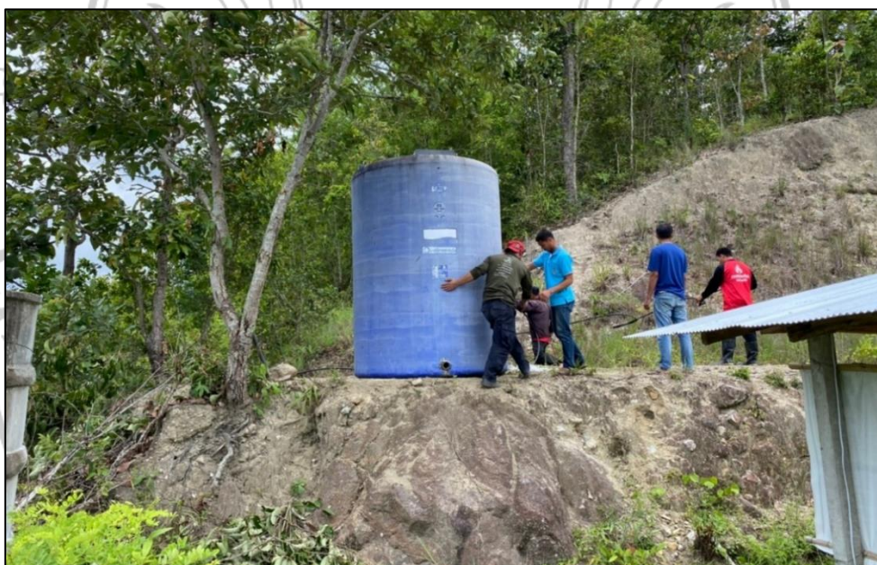
ภาพที่ 4.4 การติดตั้งถังเก็บน้ำ
