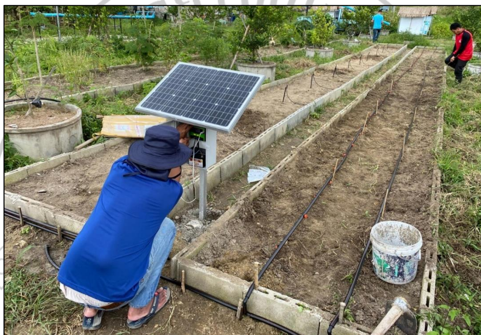
ภาพที่ 4.6 การติดตั้งโซลินอยด์
