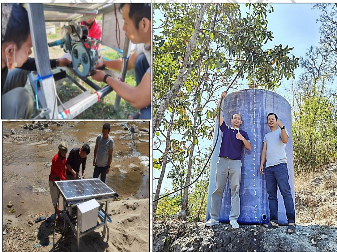
ภาพที่ 4.14 การติดตามและประเมินผลการใช้งานหลังการติดตั้ง
